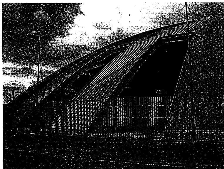
Zadar, rukometna dvorana
