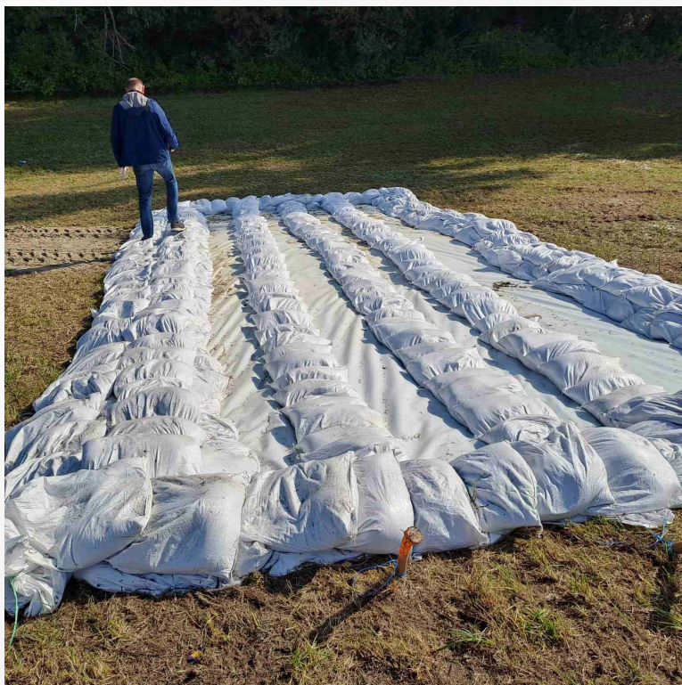
Slika 8: Polaganje geomembrana i vreća na nasipu Zmajevac - Kopačevo
