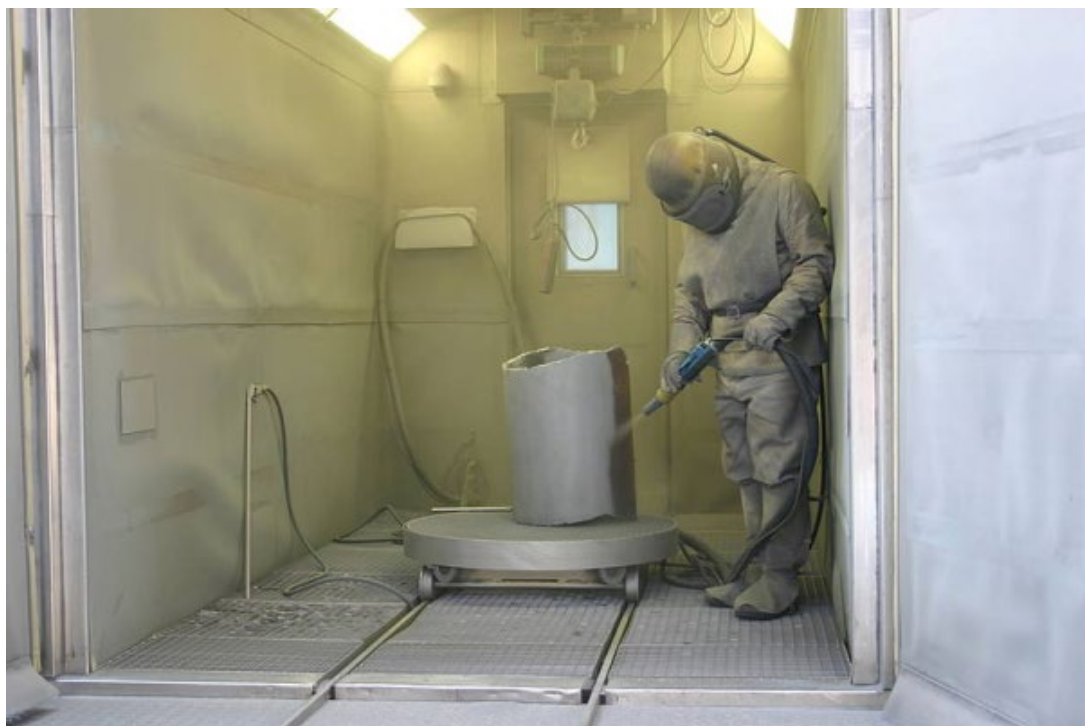
Slika 5-9: Dekontaminacija suhom obradom mlazom (izvor: EWN)
