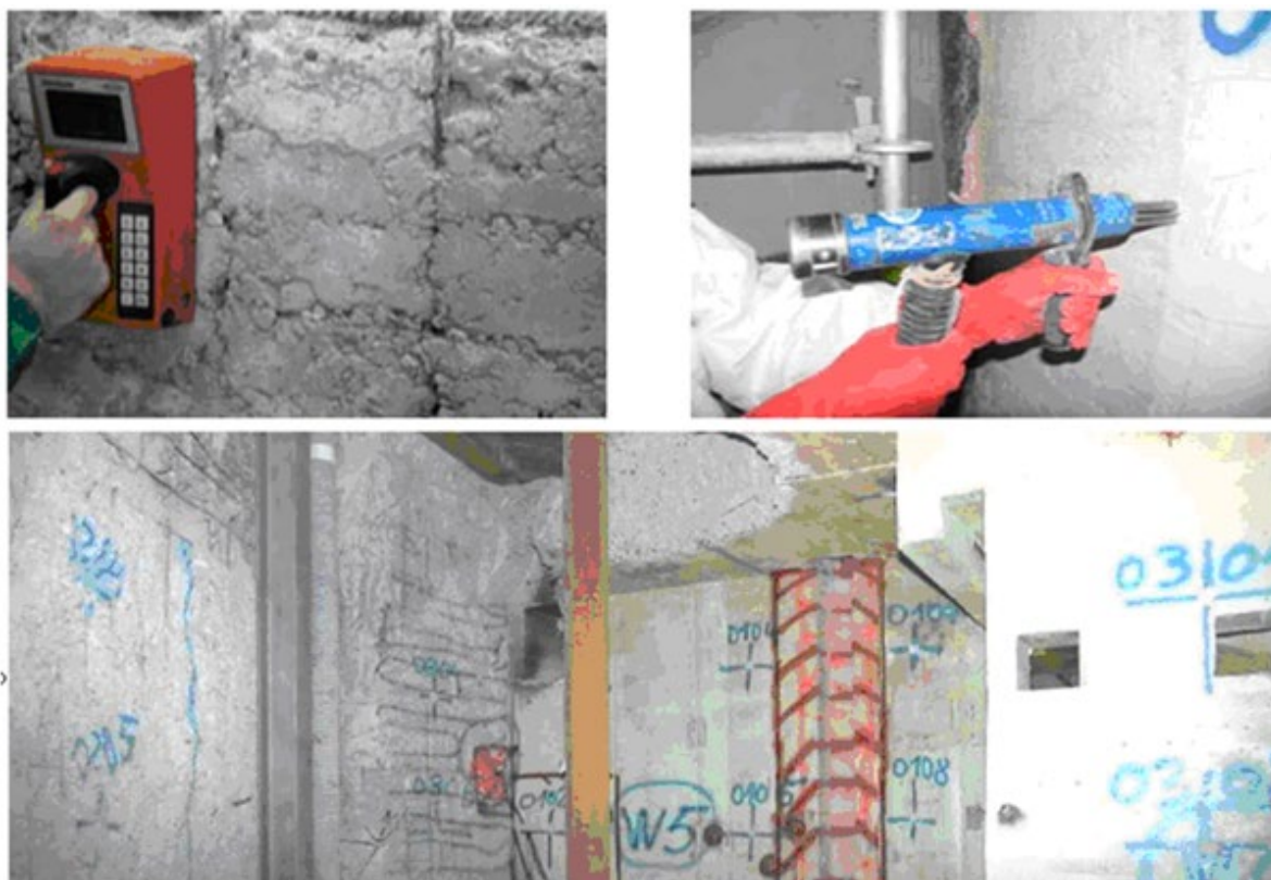
Slika 5-21: Beton u kontroliranom području tijekom radiološke karakterizacije
