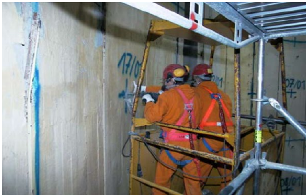
Slika 5-23: Priprema za skarifikaciju: skidanje cilindričnih zatika
