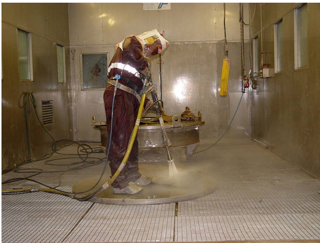
Slika 5-8: Mokra dekontaminacija visokotlačnom vodom (izvor: EWN)
