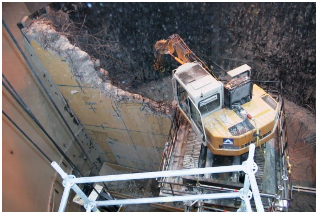
Slika 5-16: Rastavljanje betona unutar kontejnmenta
