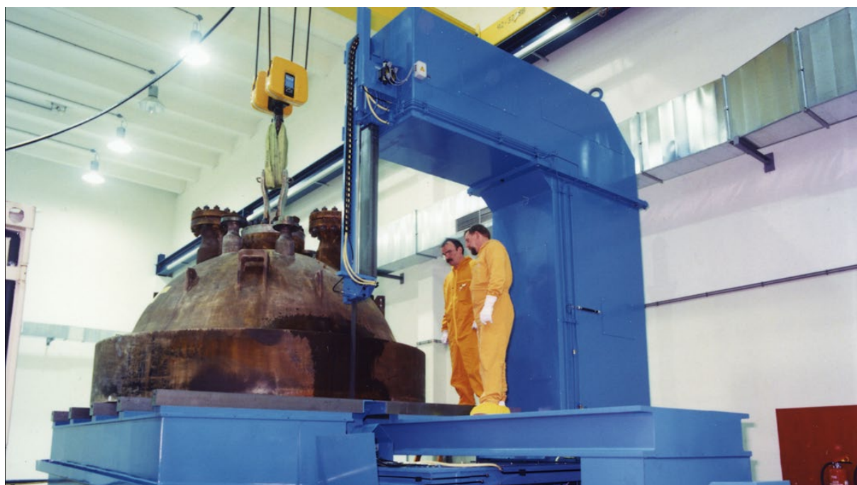
Slika 5-1: Tračna pila (izvor: NE Kahl)
