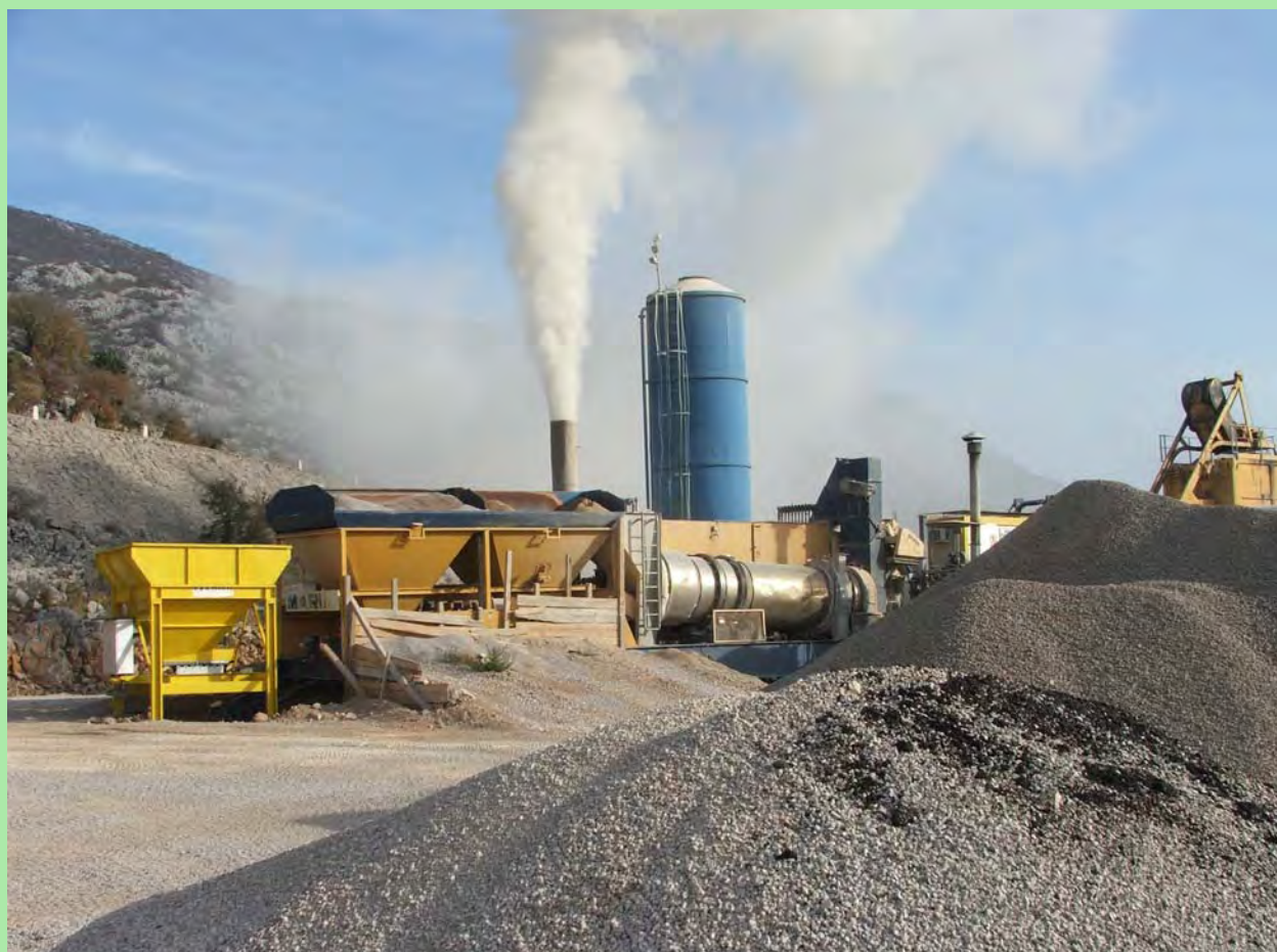
Uklanjanje betonare u Cesarici u Ličko-senjskoj županiji
