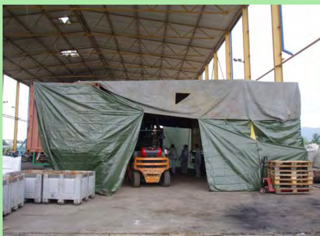
I. faza sanacije bivšeg postrojenja PUTO prepakiranjem opasnog otpada (solidifikat filter pepela)
