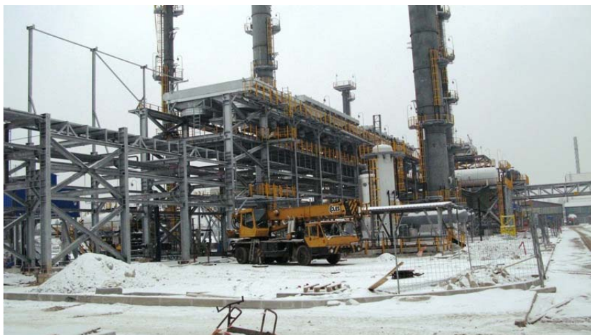
POSTROJENJE ZA IZOMERIZACIJU ( u izgradnji)
