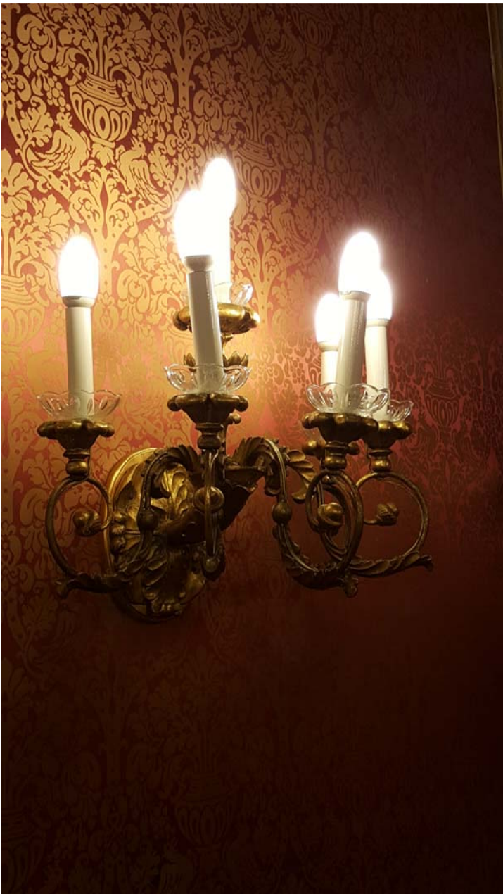
SL.3.SLIKA POSTOJEĆE RASVJETE NA ZIDOVIMA
